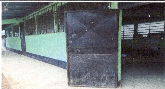
Foto 3: Sustitución de puertas
