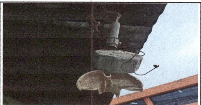
Foto 6: Reparación de cableado eléctrico + Sustitución de ducto eléctrico + accesorios
