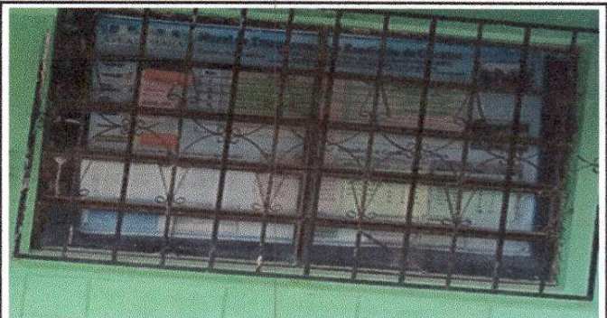
Foto 4: Sustitución de balcones de metal
