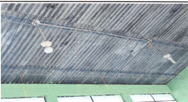
Foto 5: Sustitución de focos ahorradores
